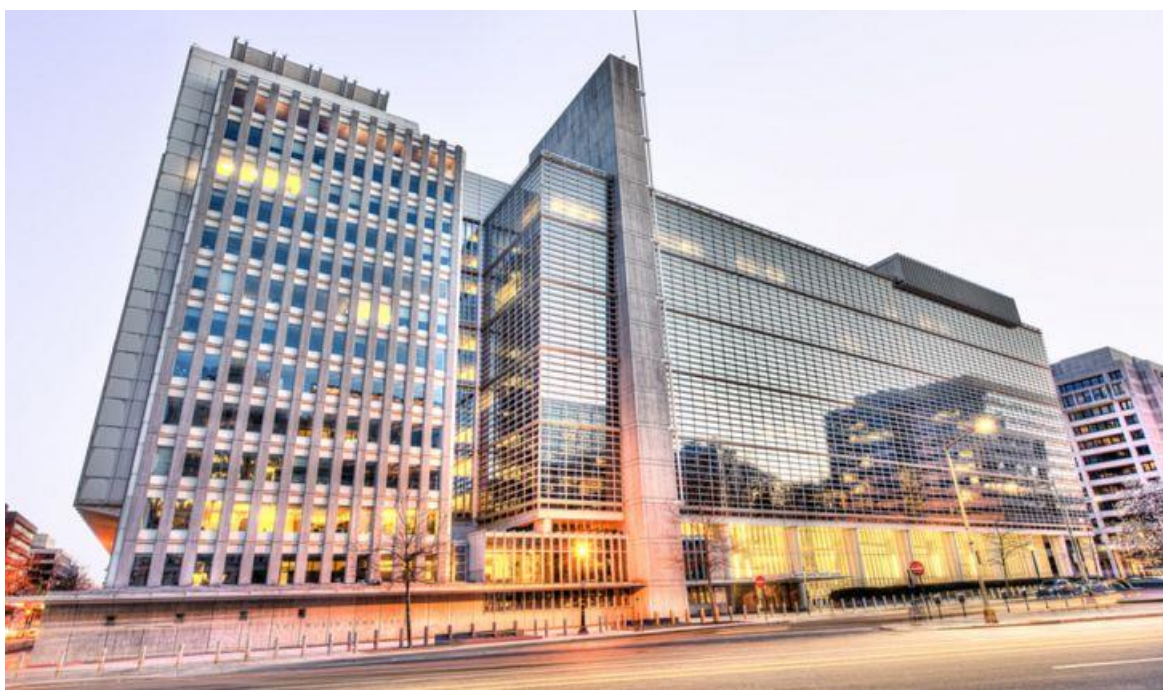
Edificio del Banco Mundial.
